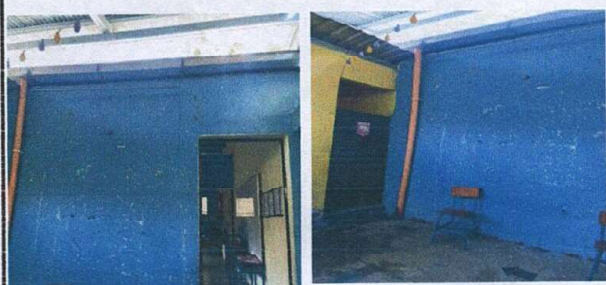
Foto 3: Sustitución de canal y bajadas para agua pluviales en modulo de aulas a un costado de los baños
