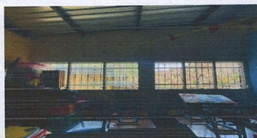
Foto 4: Sustitución de ventanas en aula 1 y aula 2
