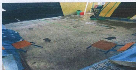
Foto 5: Sustitución de piso de concreto con acabado rustico por piso antideslizante
