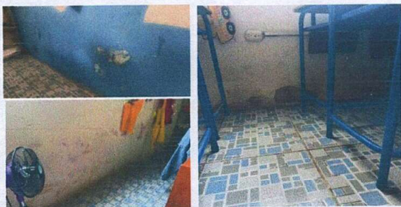
Foto 1: Reparación de paredes interiores y exteriores de aula, aplicación de zika zero salitre, repello y cernido, repello y cernido
